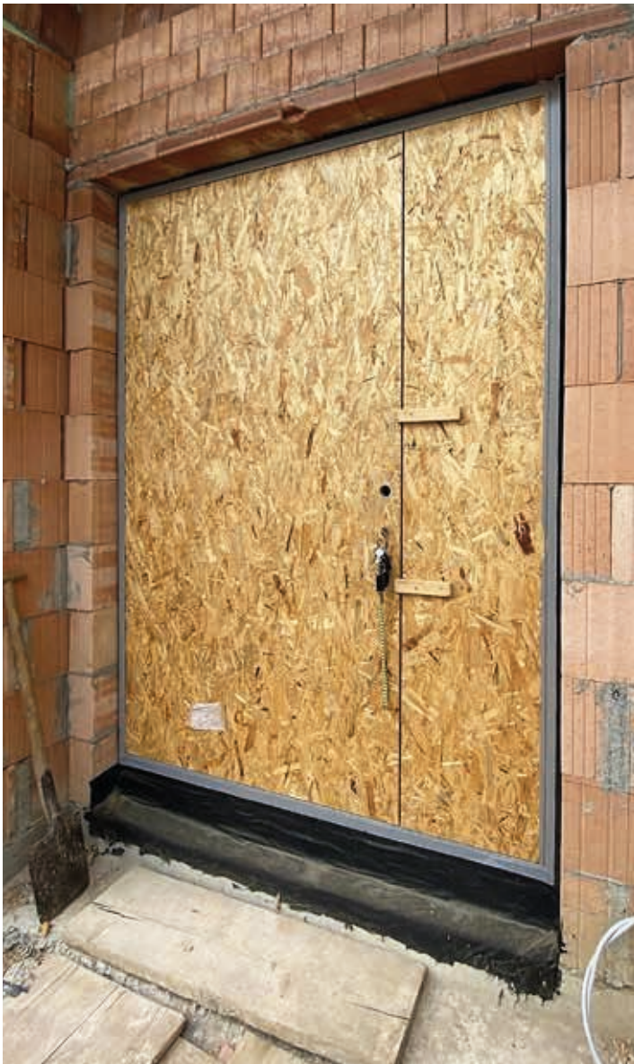
Eine Bautür mit einfachem Schloss verschließt im Neubau provisorisch den Eingang, bis die Haustür eingebaut wird. Bautüren liefert Finstral optional ab Werk.
