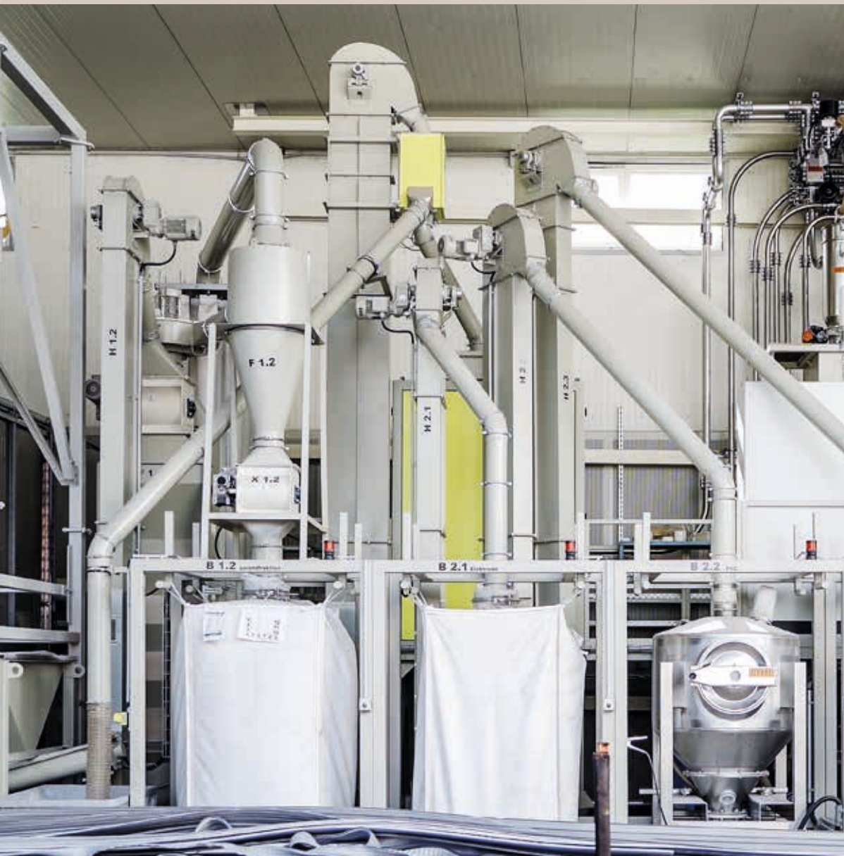
Die moderne Recyclinganlage gewährleistet die hauseigene Wiederverwendung aller Ausschussstangen und Verschnitte der selbst hergestellten Kunststoffprofile.
