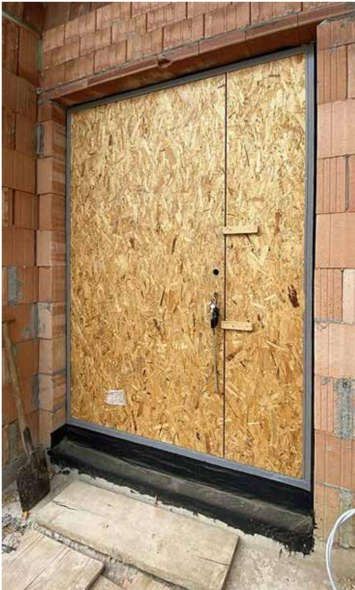
Uma porta provisória de obra com uma fechadura simples fecha provisoriamente a entrada, até se montar a porta de entrada definitiva. Opcionalmente, a Finstral fornece portas provisórias de obra de fábrica.
