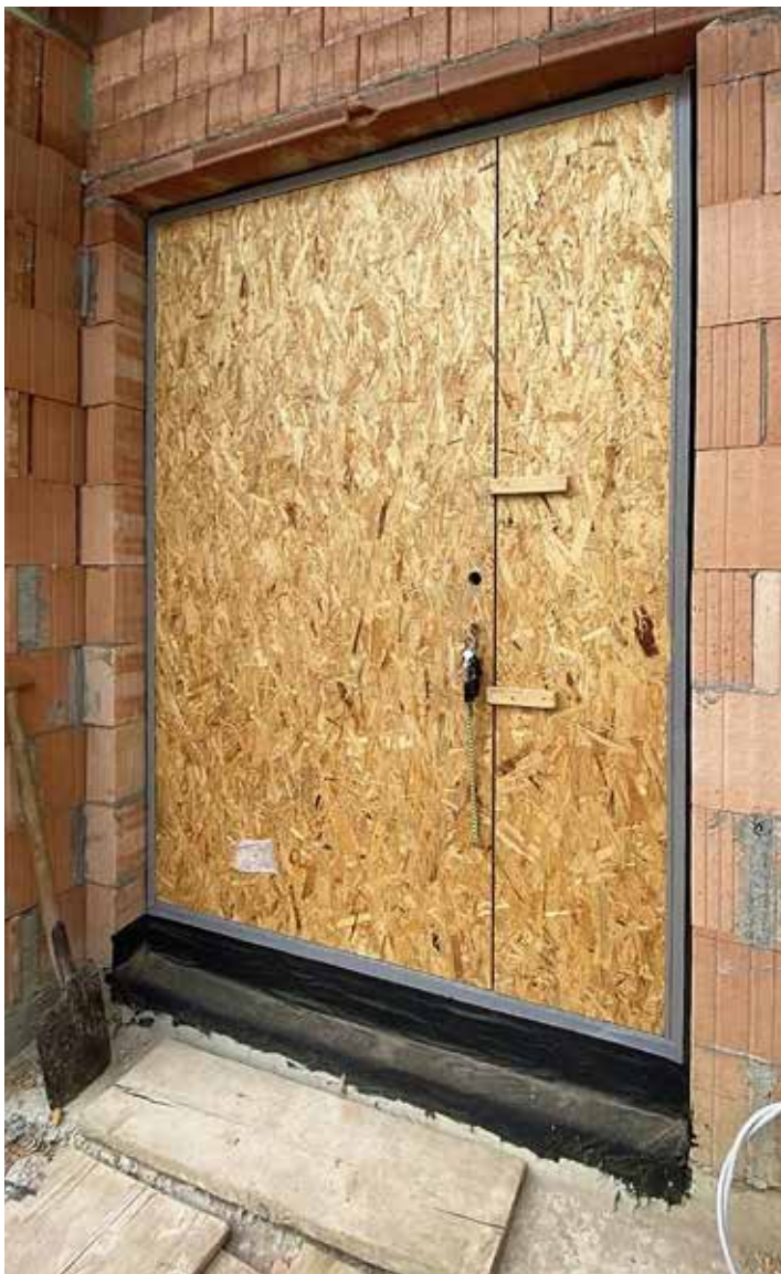
Une porte de chantier avec serrure simple ferme provisoirement l'entrée jusqu'à l'installation de la porte définitive. Finstral propose la porte de chantier en option.
