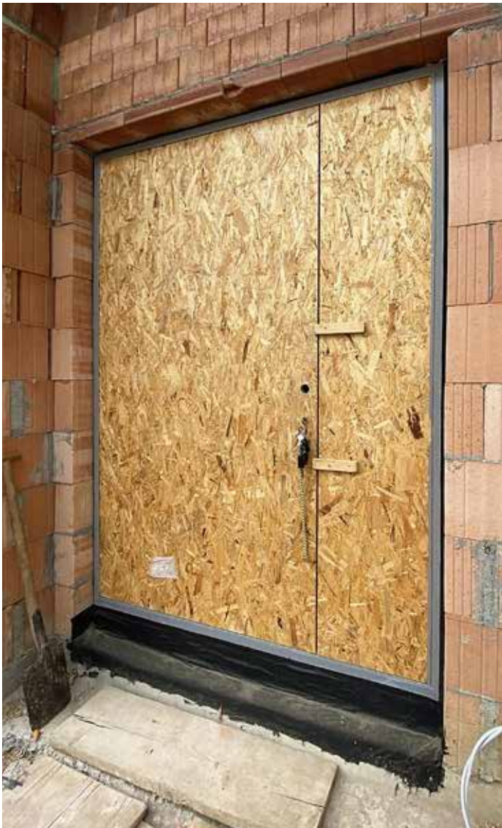
Una puerta provisional de obra con una cerradura simple cierra temporalmente la entrada hasta que se instala la nueva puerta. Finstral suministra la puerta provisional de obra, bajo pedido.
