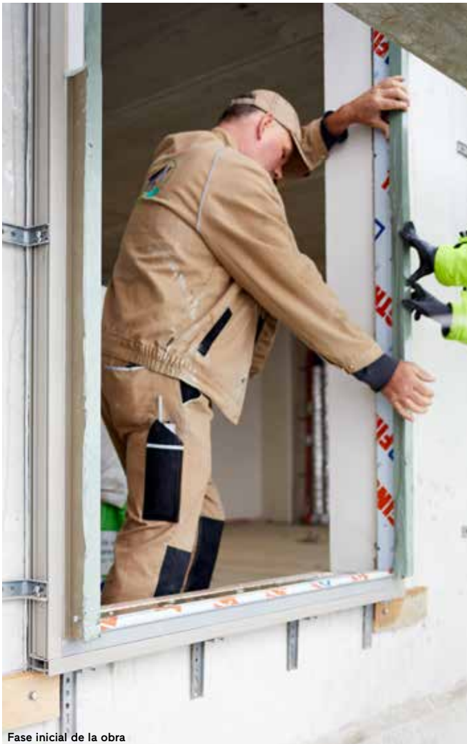
Fase inicial de la obra
