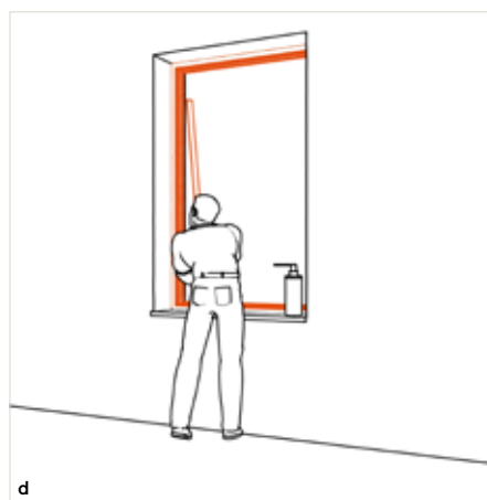
Het oude houten frame wordt aan de buitenzijde afgedekt – en dus ook beschermd tegen weersinvloeden. Vervolgens kan de vleugel worden ingehangen.
