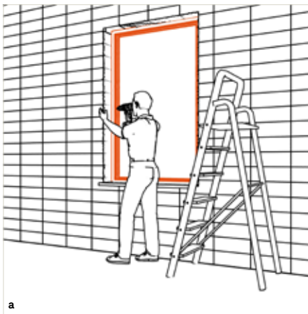
Het frame wordt in de dagkant gemonteerd tijdens de ruwbouwphase, de zogenaamde natte bouwphase.
