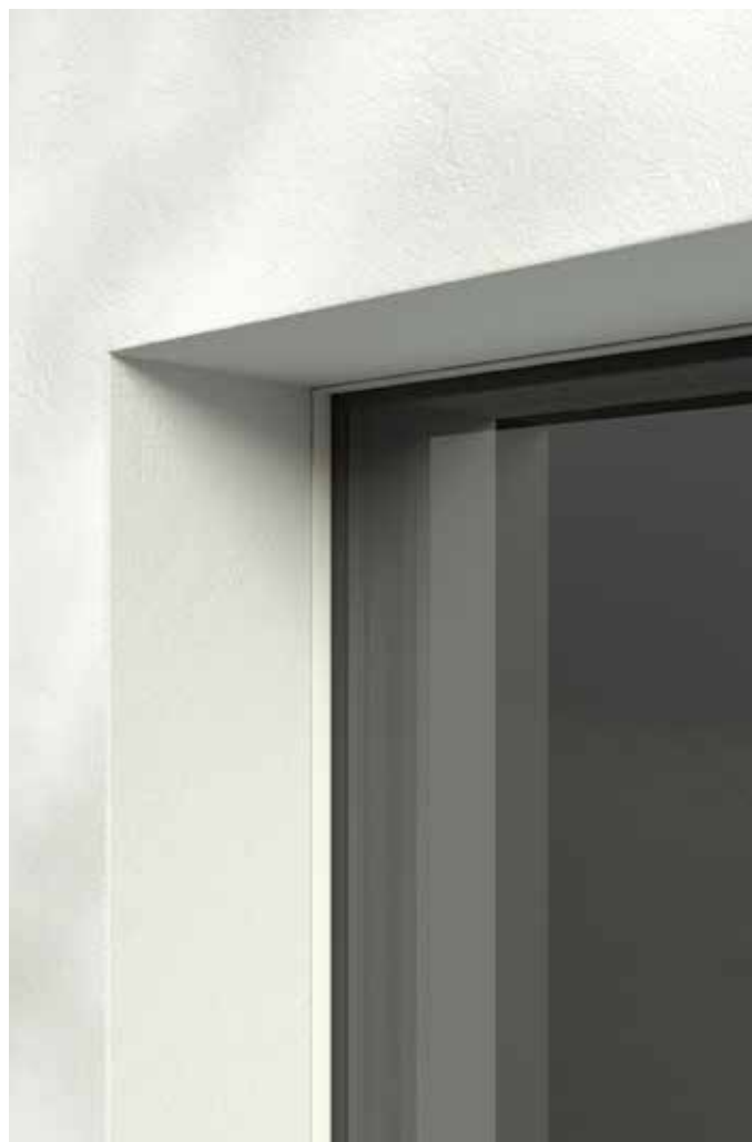
verdoken montage van het frame
